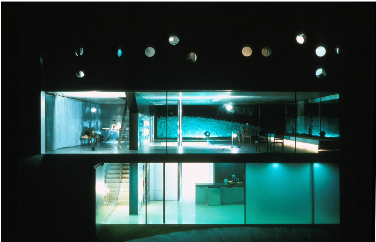
4.49 Maison à Bordeaux. Platform in topmost position, the piston clearly visible.
